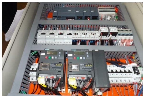
Figura 7. Protótipo em fase de montagem
