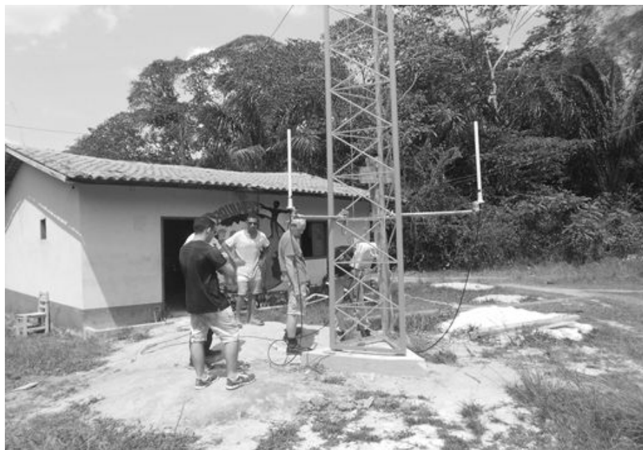
Figura 5. Instalação da Estação Rádio Base (ERB) e equipamentos irradiantes do sistema de telefonia na torre da comunidade Campo Verde.
