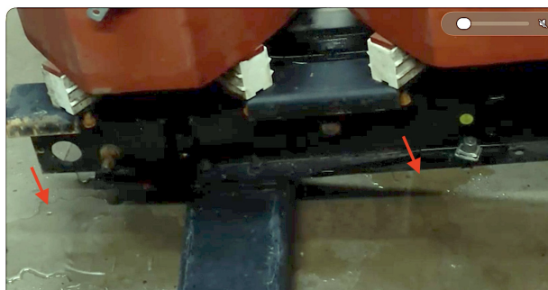
(a) Estado do transformador antes do processo de recuperação.
