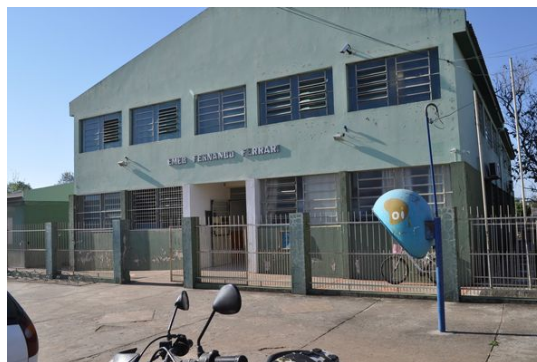
Figura 2: Fachada da EMEB Fernando Ferrari
