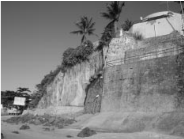
Figura 8 - Obras de proteção costeira.
