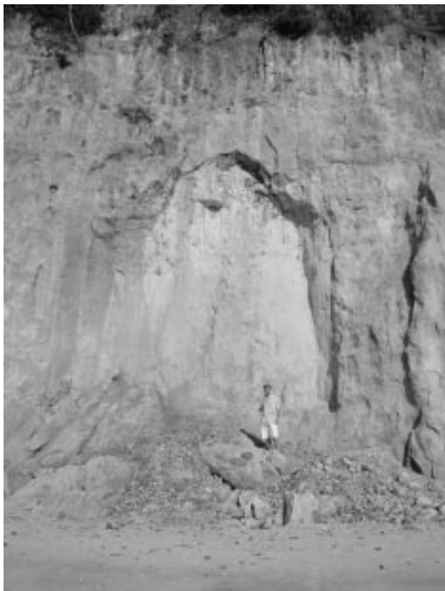
Figura 5 - Movimento de massa no final do sub-trecho 1.
