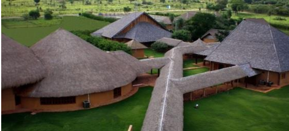
Figura 1: Vista aérea do Centro de Convenções.
