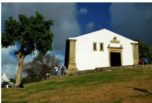
Figura 9: Casa da Pólvora
