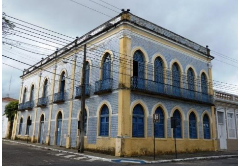
Figure 7: Casarão dos azulejos
