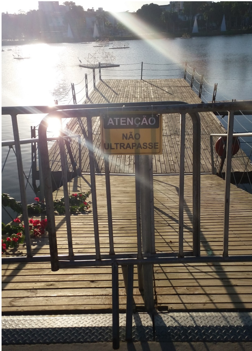
Figura 6: Rampa de acesso ao pier da lagoa
