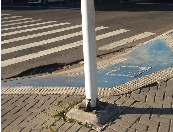
Figura 5: Rampa de acesso na calçada do anel externo
