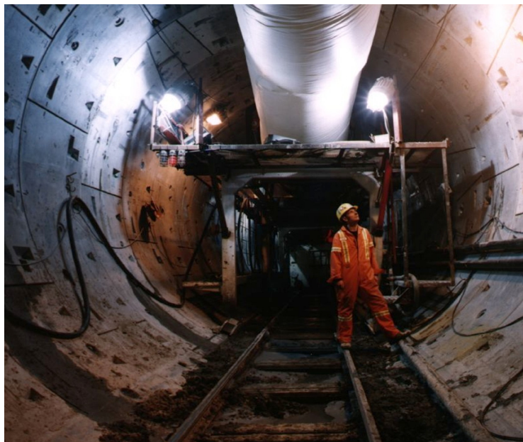
Figura 3: Execução do Projeto Twin Tunnels da linha de metrô Sheppard de Toronto (Canadá)
