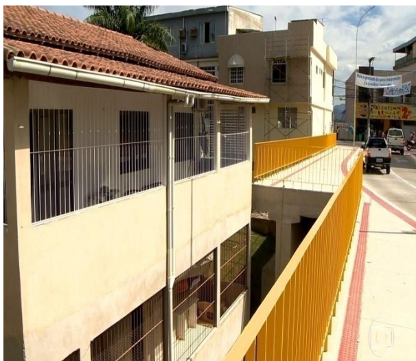
Figura 3. Distância das moradias ao viaduto José Passos
