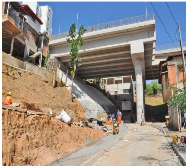
Figura 1. Obras do Viaduto José Passos
