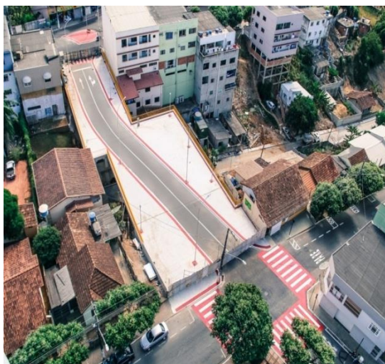
Figura 2. Imagem aérea do Viaduto José Passos
