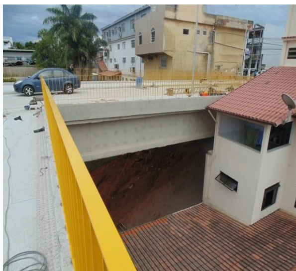
Figura 4. Rachaduras nas residências.
