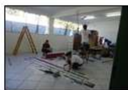
Revitalização, pintura e organização do espaço com as licenciandas e pais.
