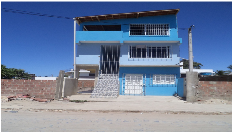
Foto 04 - Construção de privês na Rua Salina Principal - Comunidade Pantanal
