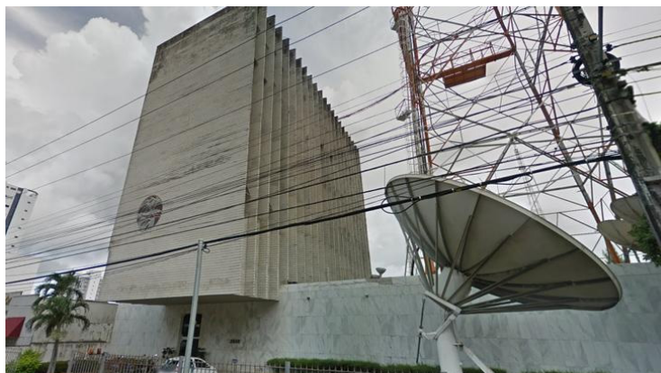
Figura 4 - Prédio onde funcionou a TV Manchete Fortaleza
